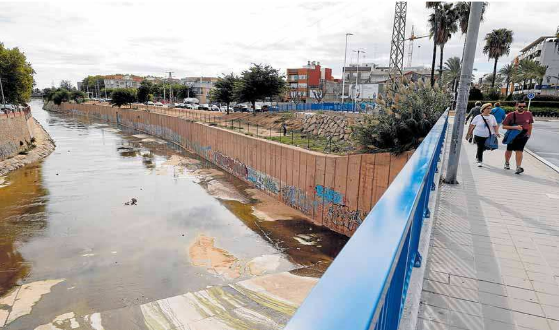
El cauce del barranco del Poyo entre Massanassa y Catarroja, con el tendido eléctrico a la derecha. JESÚS SIGNÉS
